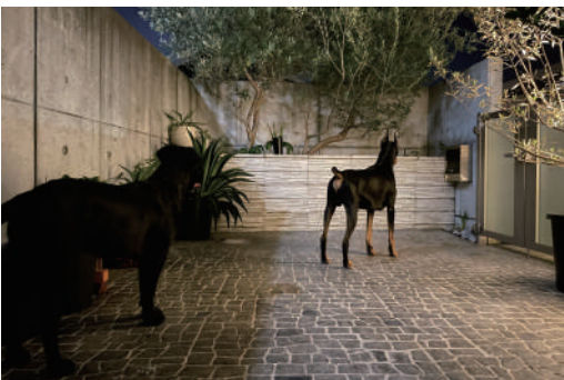
打ち出しコンクリートとスタンプコンクリートで愛犬も快適
