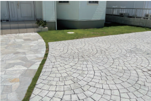
アプローチは天然石、駐車場はスタンプコンクリートで地中海風に
